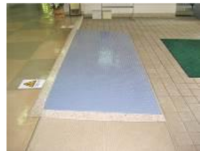
玄関へスロープ増設
