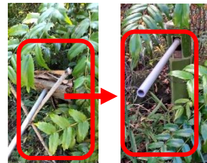
茶室つくばいの修繕
