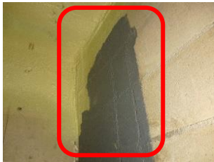
特別収蔵庫漏水箇所修繕 (防水塗料、発砲ウレタン塗布)
