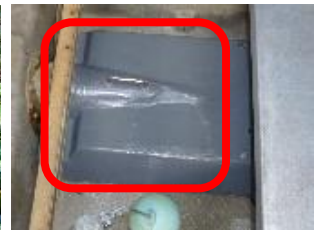
冷却塔ストレーナー修繕
