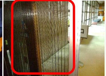
換気のための網戸設置
