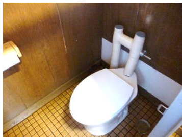
トイレの洋式化工事
