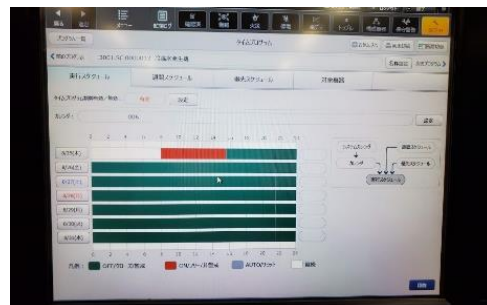
冷温水発生機運転時間短縮 【ガス使用量圧縮】
