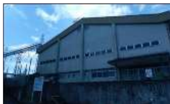
東金子地区体育館外観
